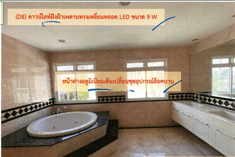
ขัดลอกผิวหน้าพื้นหินอ่อน พร้อมขัดเงา (ขัดน้ำ/ผงขัด)
