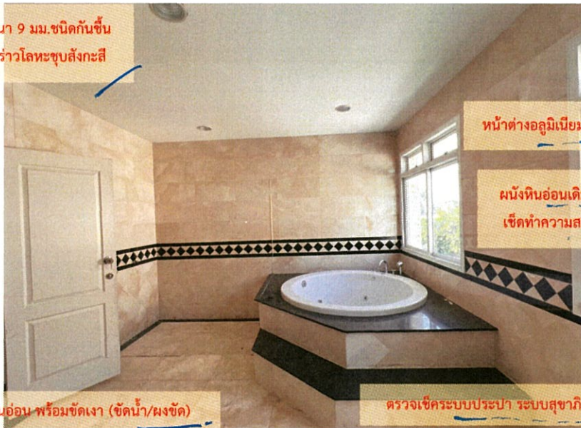
ขัดลอกผิวหน้าพื้นหินอ่อน พร้อมขัดเงา (ขัดน้ำ/ผงขัด)
