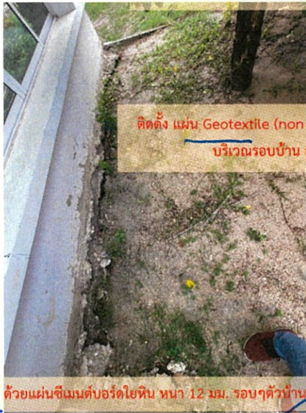
ติดตั้ง แผ่น Geotextile (non waven)พร้อมโรยหินเกล็ดเม็ดเล็ก บริเวณรอบบ้าน สูงไม่น้อยกว่า10 cm.
