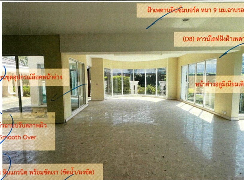
ฝ้าเพดานยิปซัมบอร์ด หนา 9 มม.ฉาบรอยต่อเรียบ โครงคร่าวโลหะชุบสังกะสี (พร้อมทำหลุมฝ้า)
