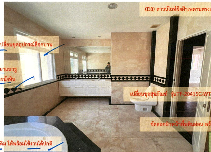
ขัดลอกผิวหน้าพื้นหินอ่อน พร้อมขัดเงา (ขัดน้ำ/ผงขัด)
