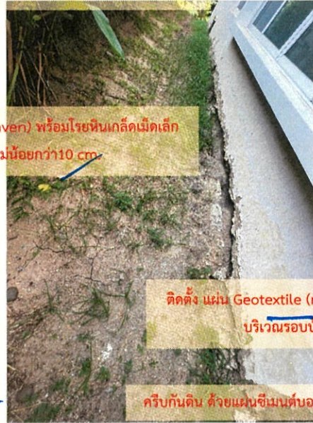
ติดตั้ง แผ่น Geotextile (non waven)พร้อมโรยหินเกล็ดเม็ดเล็ก บริเวณรอบบ้าน สูงไม่น้อยกว่า10 cm.
