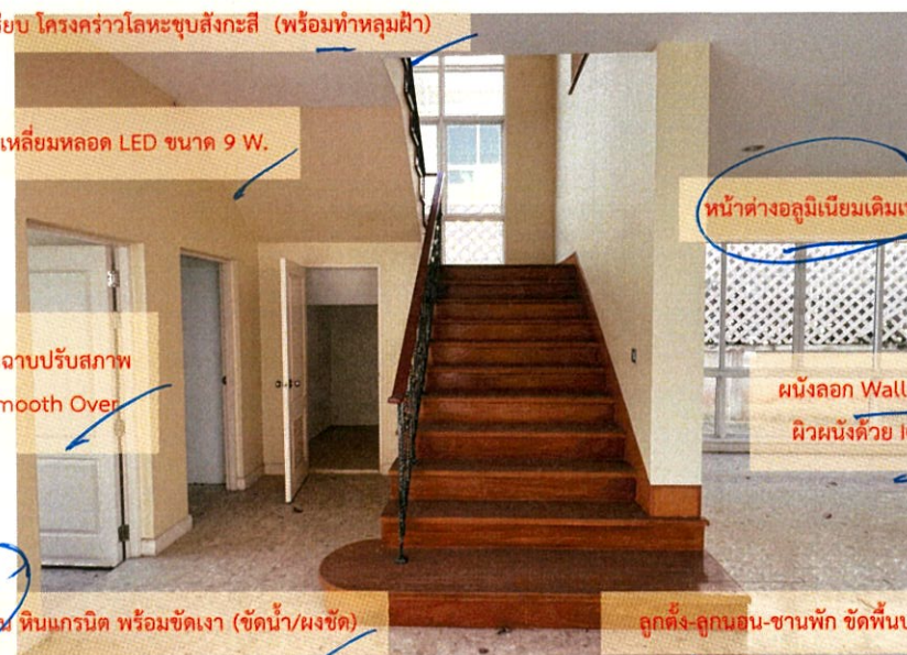
ขัดลอกผิวหน้าพื้นหินอ่อน หินแกรนิต พร้อมขัดเงา (ขัดน้ำ/ผงขัด)
