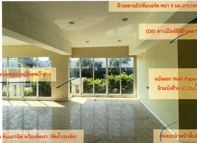
ขัดลอกผิวหน้าพื้นหินอ่อน หินแกรนิต พร้อมขัดเงา (ขัดน้ำ/ผงขัด)
