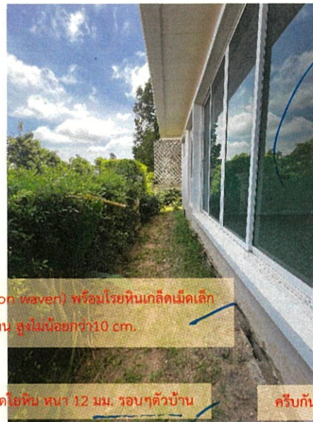
ติดตั้ง แผ่น Geotextile (non waven)พร้อมโรยหินเกล็ดเม็ดเล็ก บริเวณรอบบ้าน สูงไม่น้อยกว่า10 cm.
