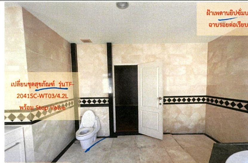
ตรวจสอบเช็คระบบประปา ระบบสุขาภิบาลเดิม ให้พร้อมใช้งานได้ปกติ
