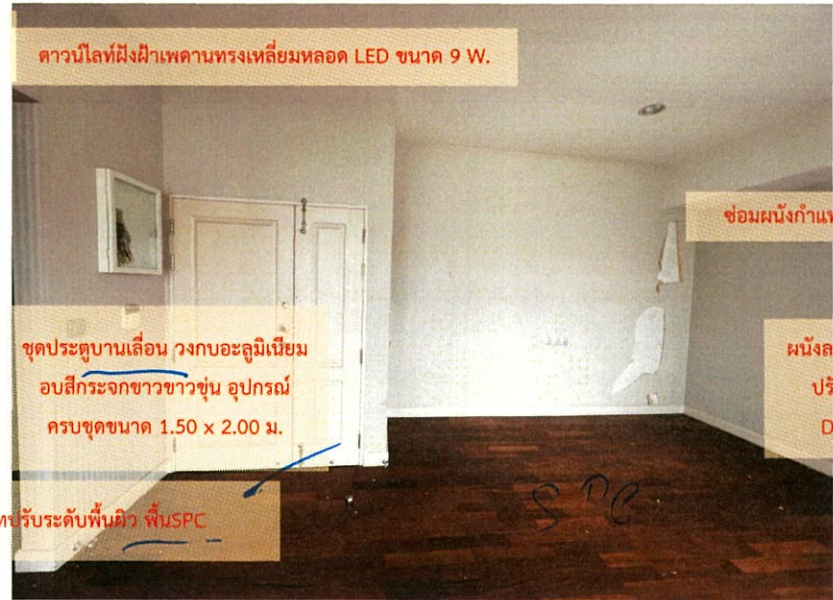
ฝ้าเพดานยิปซัมบอร์ด หนา 9 มม.ฉาบรอยต่อเรียบ โครงคร่าวโลหะชุบสังกะสี
